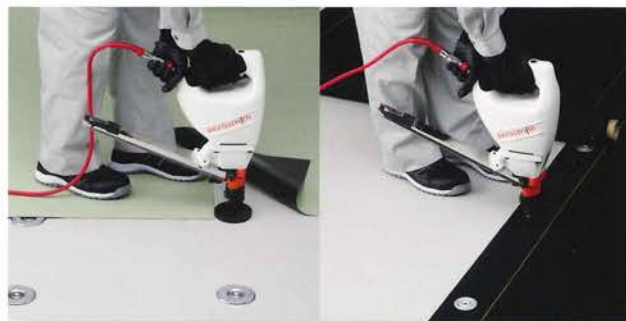
シート防水工法
