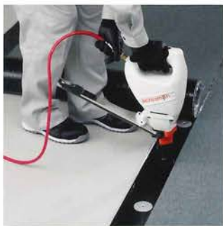
改質アスファルト防水工法
